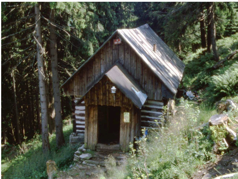
Ryc. 2. Domek myśliwski pod Śnieżnikiem (stan w 2001 r.). Fot. M. Furmankiewicz
